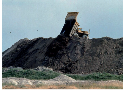
Ein Kipplaster lädt Aushubmaterial im Bereich der Nordbrücke ab
