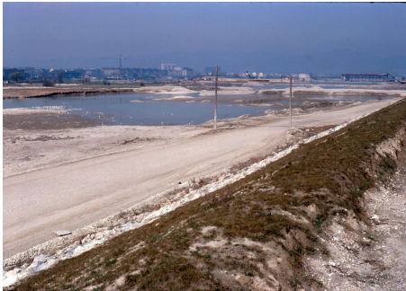
Bau der Donauinsel, Bereich Reichsbrücke, 1981
