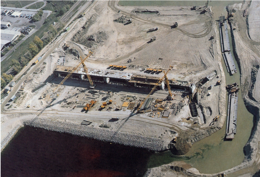
Baustelle des Wehres 2
